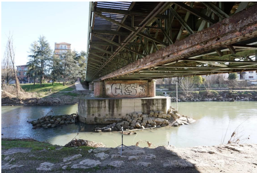
Figura 5-3: Fotografia – Dettaglio della pila
