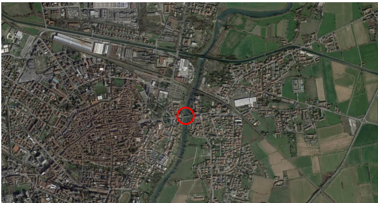
Figura 1-1: Inquadramento – vista satellitare dell’opera in oggetto (Fonte: Google Earth)
