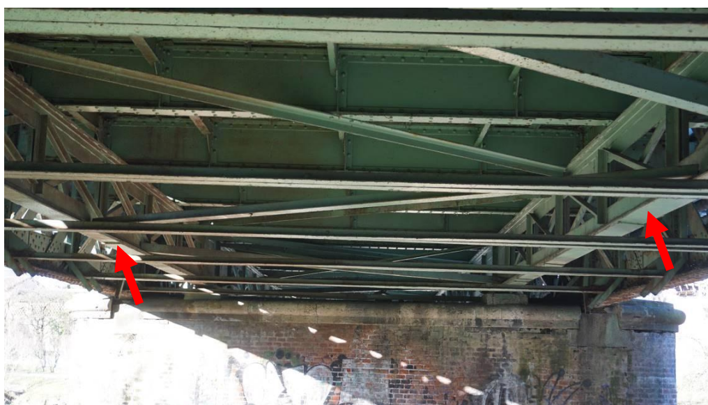
Figura 5-10: Fotografia - Dettaglio dell'intradosso del ponte con indicate, con una freccia rossa, le reticolari aggiunte a posteriori
