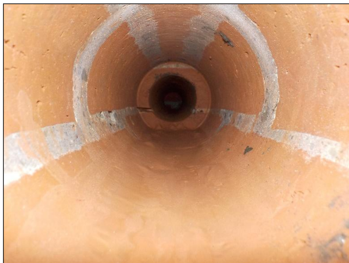
Figura 10-1: Ripresa fotografica dell'indagine endoscopica eseguita sulla pila
