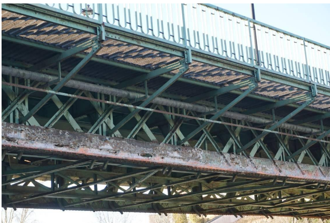
Figura 5-6: Fotografia – Dettaglio del corrente inferiore della trave reticolare
